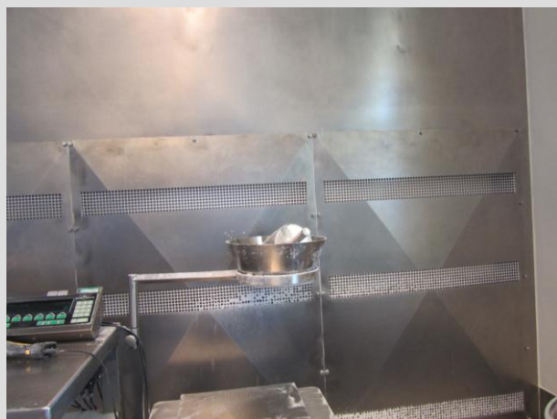
Figur 6.15. Udsugning ved afvejning af nikotinpulver
