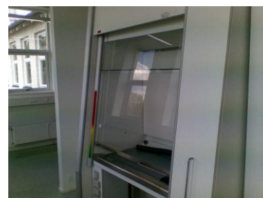
Figur 5.2. Delvis indkapslet proces (stinkskab)
