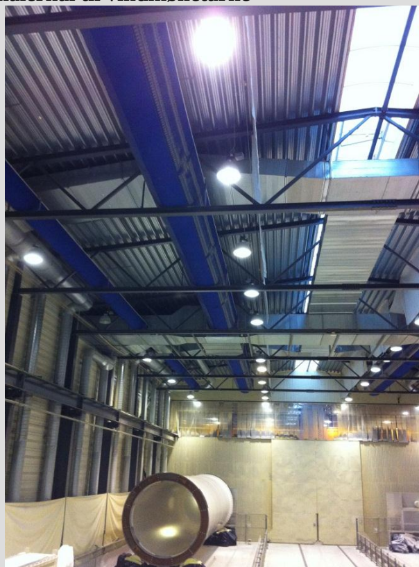
Figur 5.10. Brug af poseindblæsning i stor hal, hvor vindmølleårne males. Udsugningen er placeret lige bagved vindmølleårnet.
