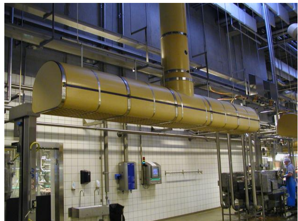
Figur 6.37. Indblæsningsarmaturer til fortrængning
