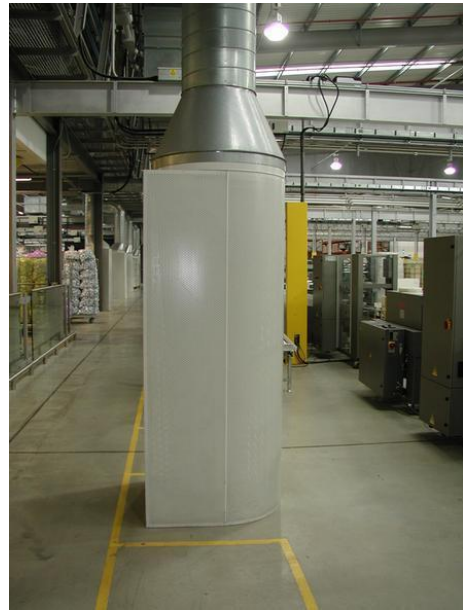
Figur 6.36. Gulvplaceret indblæsningsarmaturer til fortrængningsventilation
