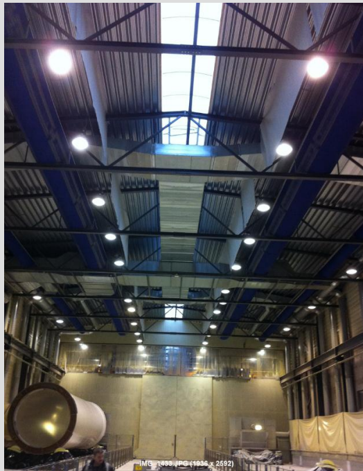
Figur 5.16. Lodrette lofttæpper til bremsning af strømning
